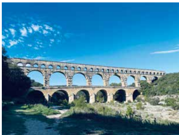
圖卅八 加爾水道橋真正跨過河道
